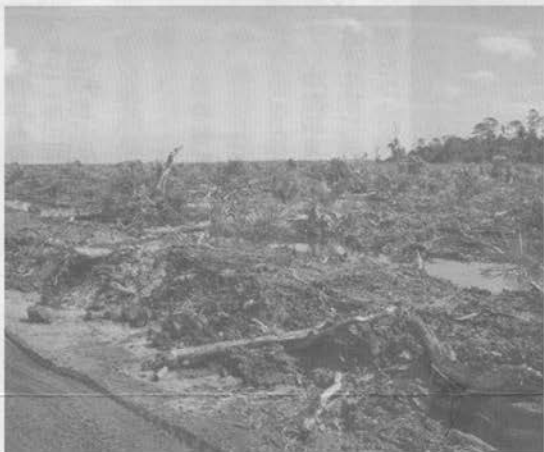
排水路から浚渫された土砂
